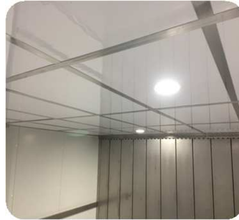
Falso techo con placas plastificadas en blanco y plafón led integrado
