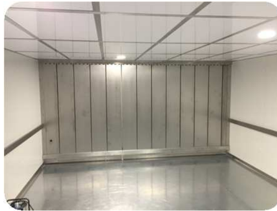
Panel de circulación del aire fabricado en acero inoxidable
