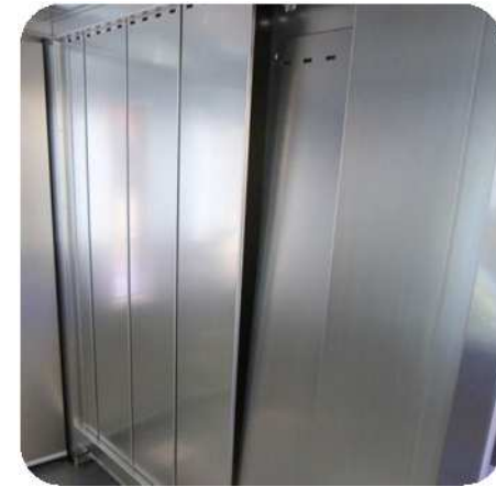
Falso plafón lateral desmontable para facilitar la limpieza
