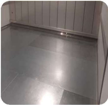
Suelo con chapas de acero galvanizado de 3mm
