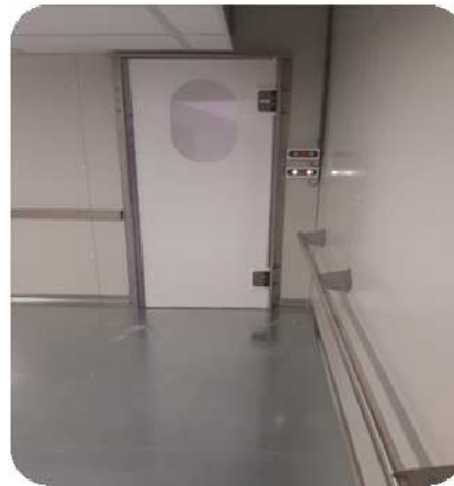
Doble puerta batiente para minimizar la formación de hielo
